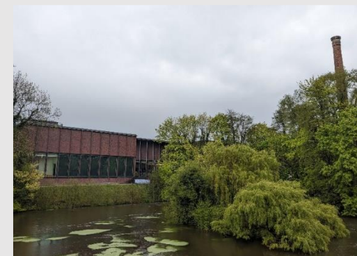
Blick auf die Ilmenau und die Ratsmühle
